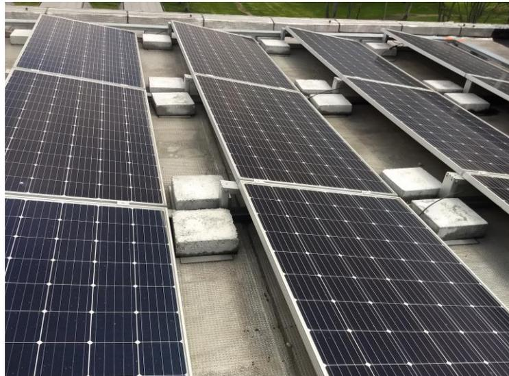
**FIGURA 14 - EXEMPLO DE UTILIZAÇÃO DE ESTRUTURAS DE SUPORTE PARA PAINÉIS FOTOVOLTAICOS EM TELHADOS PLANOS.**
