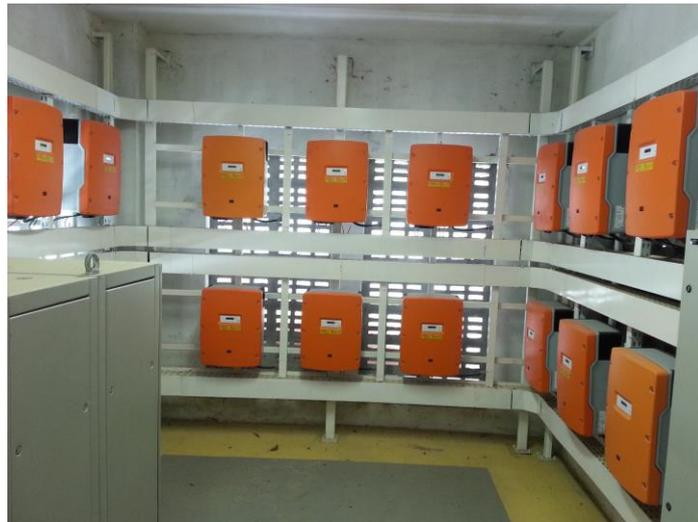
**FIGURA 27 - EDIFICAÇÃO RESPONSÁVEL POR ACOMODAR OS INVERSORES DE UM SISTEMA FV, GARANTINDO VENTILAÇÃO ADEQUADA E ABRIGO DO TEMPO.**
