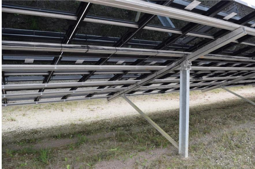
**FIGURA 26 - ESTRUTURA DE FIXAÇÃO DOS MÓDULOS NA USINA SOLAR CIDADE AZUL, EM TUBARÃO - SC.**
