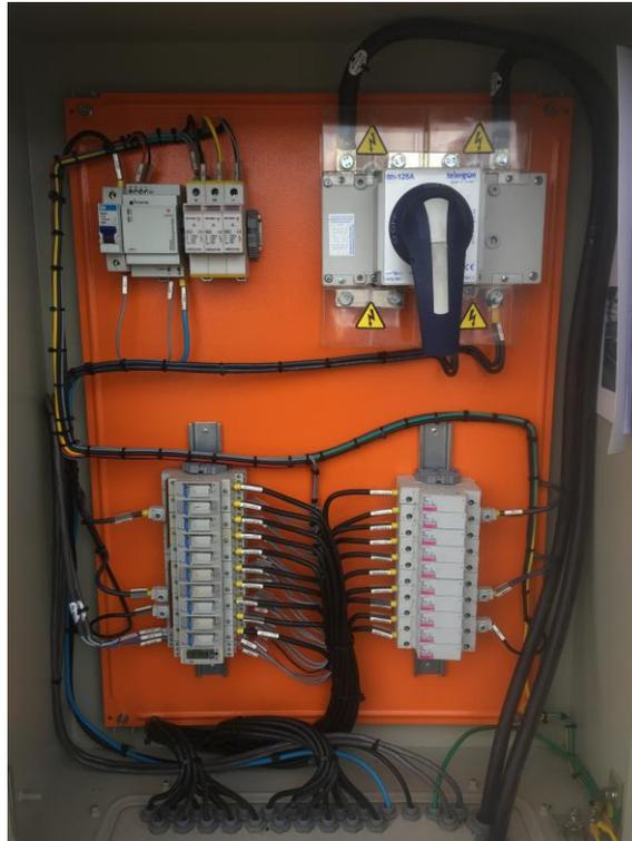
**FIGURA 15 - EXEMPLO DE STRINGBOX COM DISPOSITIVOS DE PROTEÇÃO E MEDIÇÃO E CHAVE DE SECCIONAMENTO CC.**
